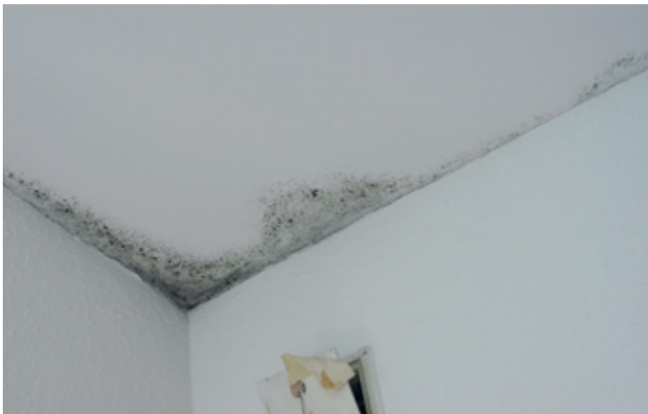
Kondensproblem. Man ser angreb af skimmelsvampe som brune, grønne, sorte, hvidlige eller rødlige pletter eller plamager. De kan have en lodden overflade.
